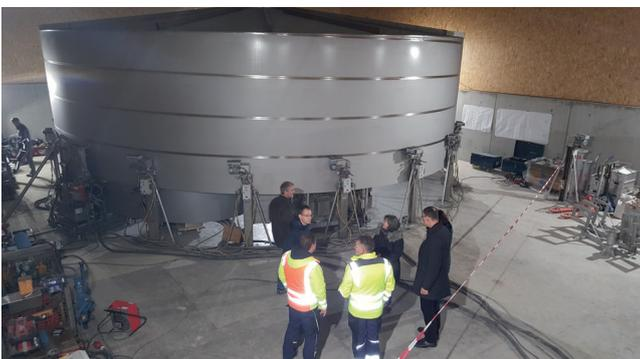
Die Wände des linken Edelstahlbehälters beim Verschweißen.
