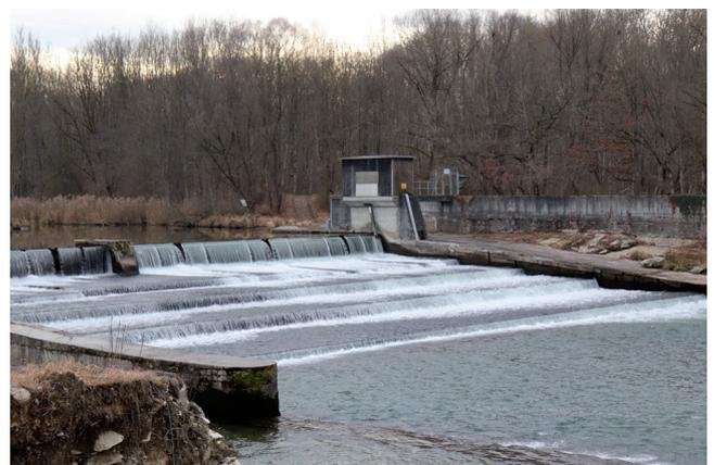
Bereits fertig erneuert ist der Schussboden am Ayer Wehr, über den das Wasser der Iller hinabströmt.
