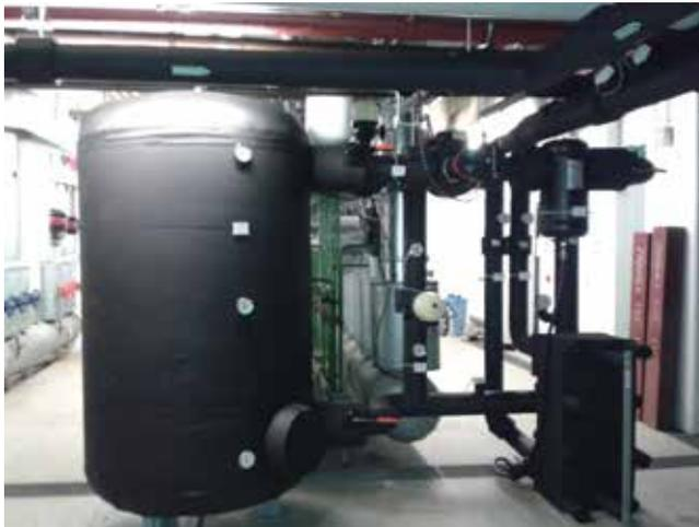
Wärmetauscher, Pufferspeicher und Verteiler-Register im Heizkeller.
