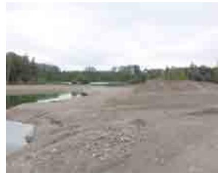
Modellierung von Flachwasserzonen und Kleingewässern im Grundwasserschwankungsbereich im Zuge der Renaturierung
